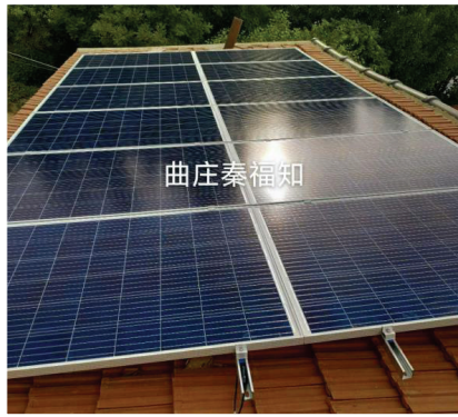
光伏发电工程
