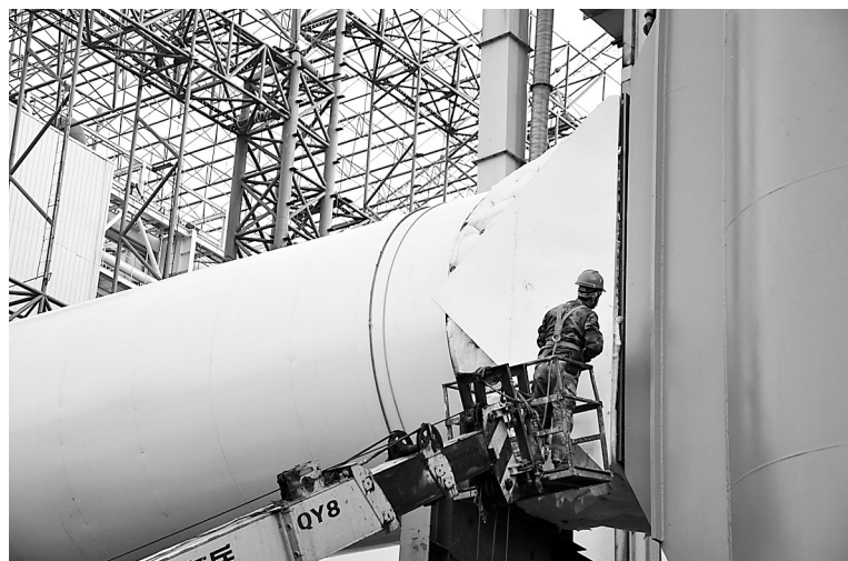
铺设保温管路
