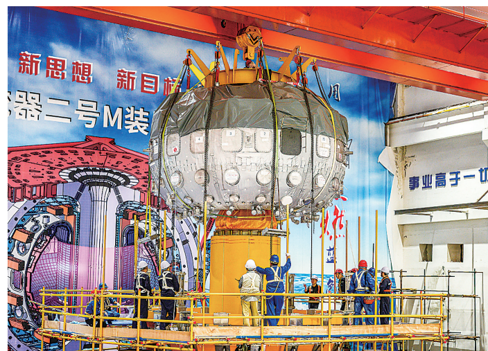
中核集团核工业西南物理研究院的工作人员在安装调试中国环流器二号M装置时进行真空室吊装作业。
