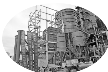
主厂房结构第一节柱首吊就位
