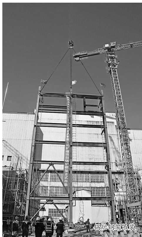
主厂房结构第一节柱首吊就位
