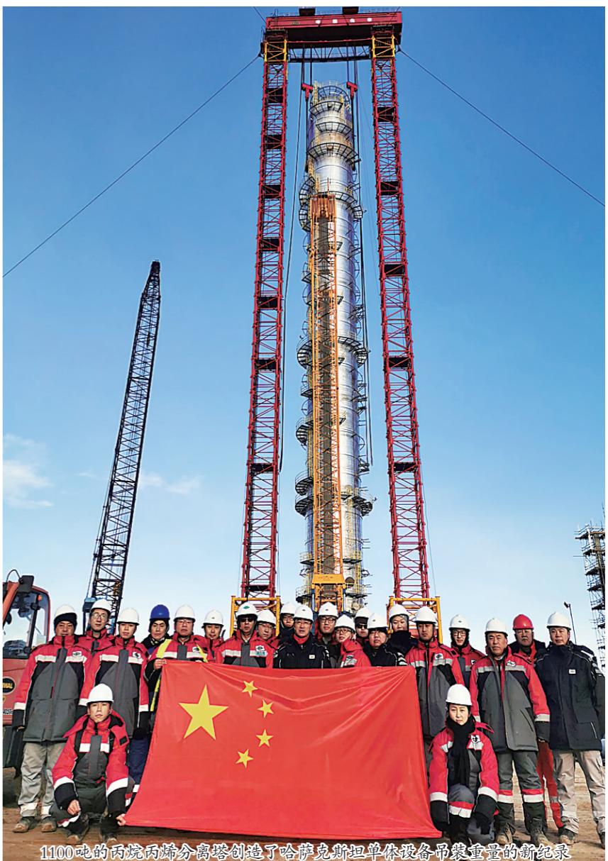
1100吨的丙烷丙烷分离塔创造了哈萨克斯坦单体设备吊装重量的新纪录
