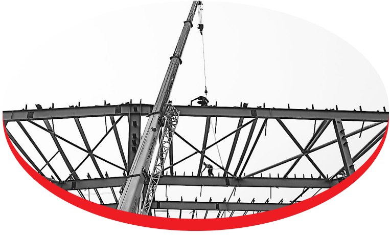
来福照明项目施工现场
