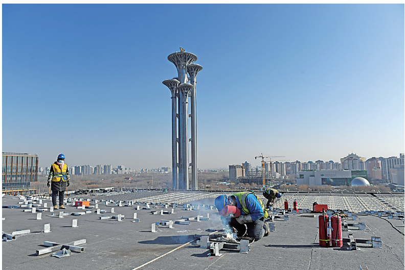
近日,施工人员在国家会议中心二期项目内施工。
