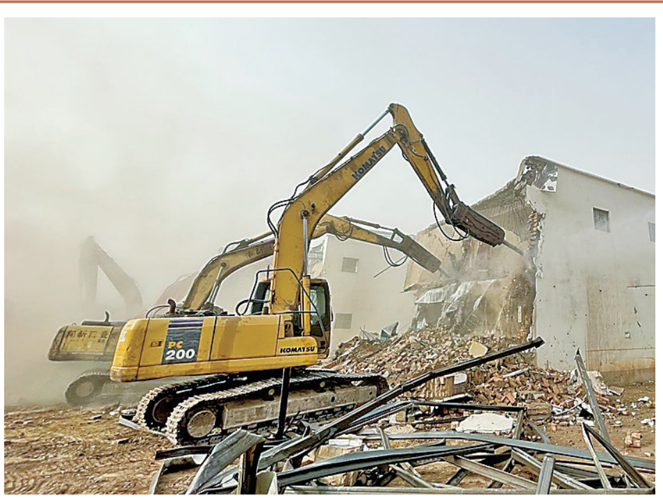
在“拆促畅增优”活动中，泊头市以违法建筑为重点，同时对私圈乱占、私搭乱建、乱堆乱放、乱贴乱挂等影响人居环境的现象进行全面清理，对一批典型违法建筑依法拆除。仅3月17日一天，就拆除各类违章建筑83处，面积31073.67平方米。
