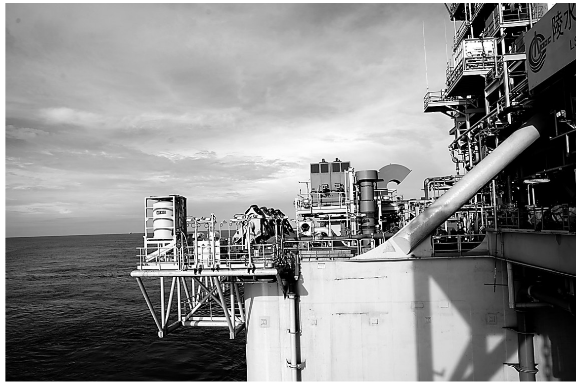
图为拍摄的“深海一号”能源站部分设施。
