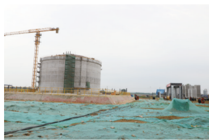
正在建设中的LNG调峰储备库项目
