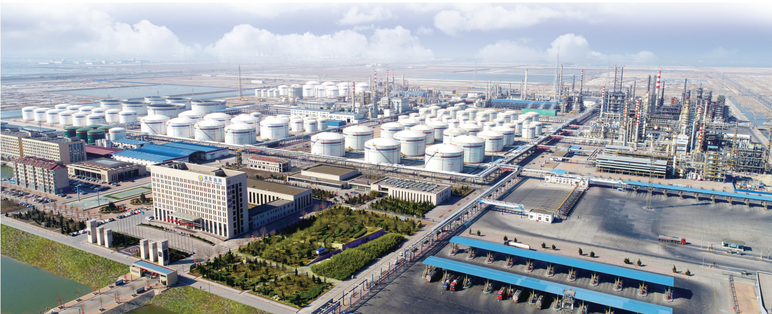
作为羊二镇的龙头企业,鑫海集团开始建设第七期项目,对当地经济的引领带动作用进一步凸显。
