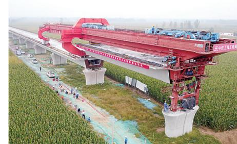
9月18日，在郑济高铁长清黄河特大桥项目段，中铁上海局标段首架方向箱梁架设完成。郑济铁路是国家“八纵八横”高铁网的重要组成部分。项目通车后，济南到郑州的通行时间将缩短至1.5小时。 新华社发
