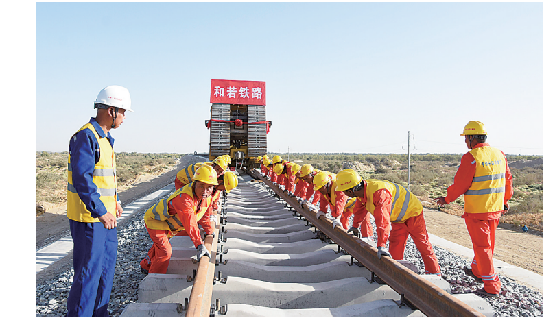
9月27日上午,中铁十四局工人正准备将钢轨合龙。当日,随着最后两条钢轨在道床上铺设完成,作为环塔克拉玛干沙漠铁路“最后一公里”的和若铁路全线铺轨贯通,为2022年开通运营奠定坚实基础。 新华社发
