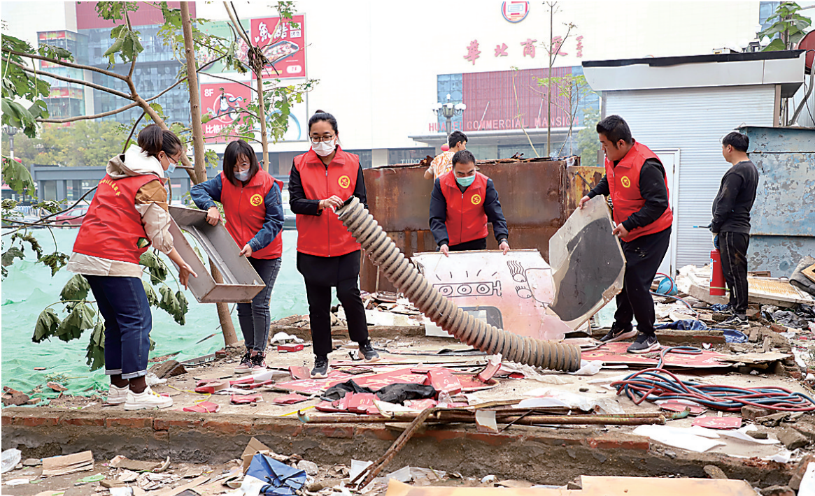
10月15日清晨，运河区市场街道办事处组织市场街社区对原渤海大厦东侧的临建、违建进行集中拆除。建筑垃圾清运完成后，市场街社区志愿者对该区域进行了清理打扫。
