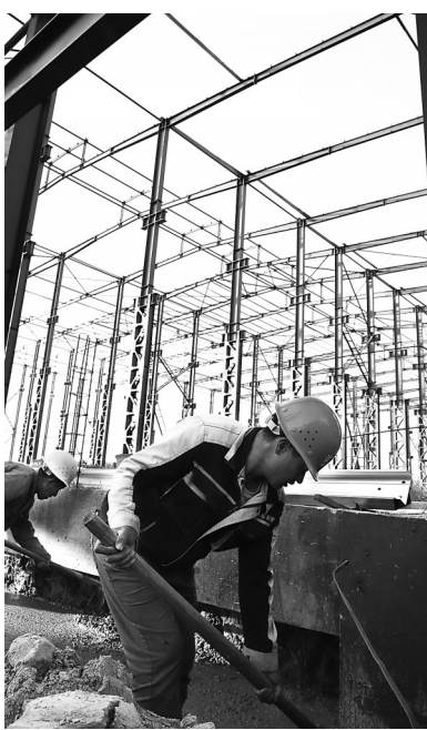
泊头市益升机械公司二期工程施工现场
