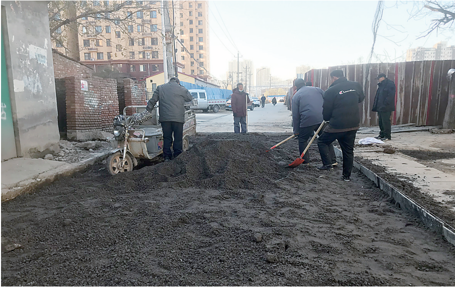
绿茵中路位于运河区隆华社区，是一条背街小巷。这条路有一段破损严重、坑洼不平，给过往行人造成不便。群众的“烦心事”，就是社区的“头等事”，乘着我市城市容貌提档升级活动的东风，隆华社区与包联单位市发改委不等不靠、特事特办，仅用两天时间，将“断层道”变成了平坦顺心的“幸福路”，居民们纷纷拍手称赞。徐利民 摄
