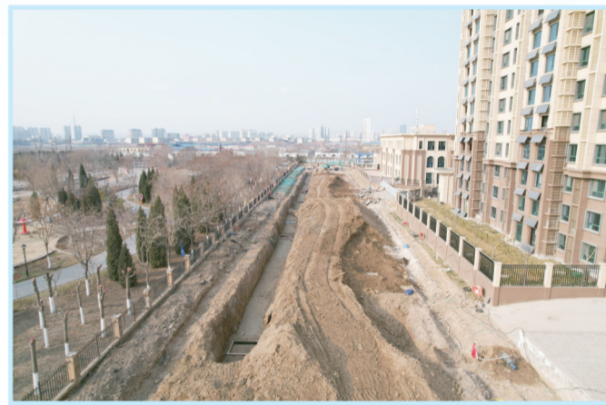
道路贯通项目长芦公园北侧规划施工现场。
