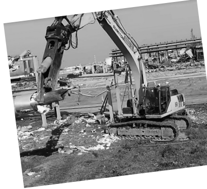
无人工程车进场拆除
