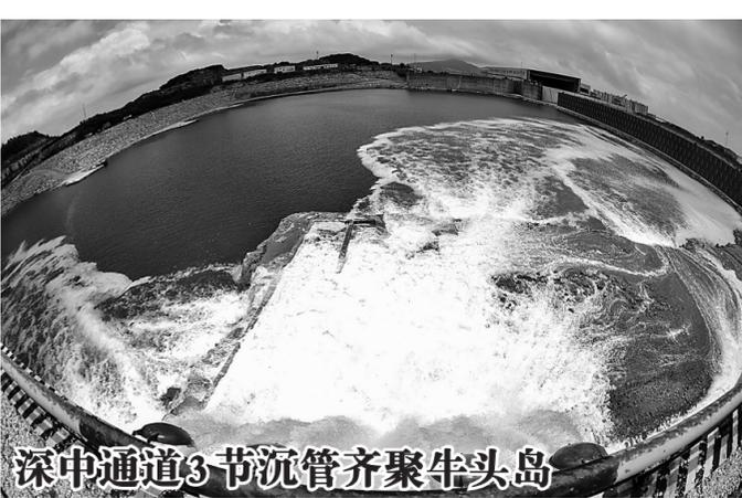
深中通道3节沉管齐聚牛头岛 日前，深中通道E20管节在中交四航局珠海牛头岛沉管智慧工厂进行浇筑，完成一次吊装。E19管节即将横移到深水区，完成卸驳的E21管节正待浇筑，3节沉管齐聚牛头岛。这3节沉管均为标准管节，分别长165米、宽46米、高10.6米，每节沉管由2255个独立的仓格组成，混凝土浇筑方量约2.9万立方米，浇筑完成后的每节沉管重达8万吨。深中通道海底隧道全长6845米，其中预制沉管管段长5035米，由32节沉管和1个最终接头组成。 新华社发
