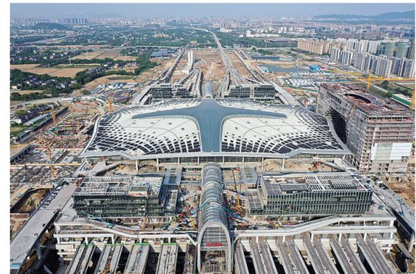
杭州西站光伏发电项目共7540块单晶硅光伏组件全部铺设完工，预计6月下旬将完成并网发电。杭州西站光伏发电项目利用站房屋顶资源，采用“自用自余、余电上网”的并网运营模式，铺设单晶硅光伏组件面积约1.5万平方米，装机容量为3兆瓦。
