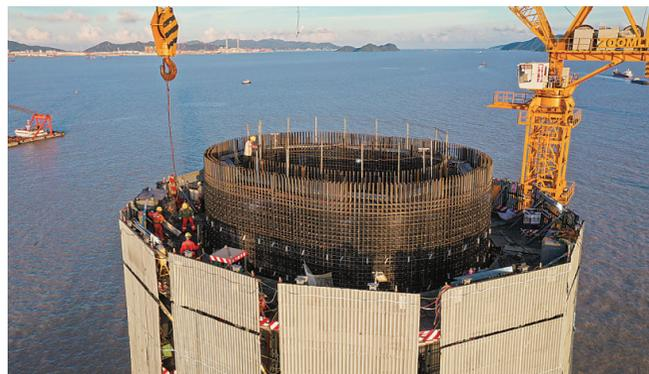
中铁大桥局承建的黄茅海大桥东塔第十二节爬模爬升到位，进入中部塔柱施工阶段。作为黄茅海跨海通道控制性工程，黄茅海大桥主跨跨径达2×720米，桥梁全长2200米。黄茅海跨海通道东起珠海市平沙镇，西接江门市斗山镇，横跨珠江口崖门入海口黄茅海水域，线路全长约31公里。建成通车后，将与港澳澳大桥、深中通道、虎门大桥、南沙大桥等共同组成粤港澳大湾区跨海跨江通道群。
