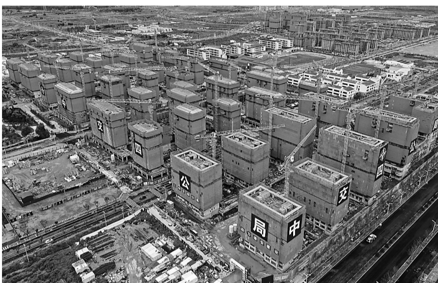
目前，河北雄安新区启动区中交启园、容东片区雄安·电建智汇城等首批市场化开发项目建设正酣，各项施工正在按照节点有序推进。
