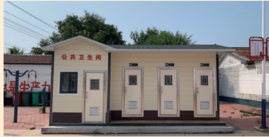
潘房子村新建成的公共卫生间既为村民提供了方便,又让村庄环境更加干净整洁。
