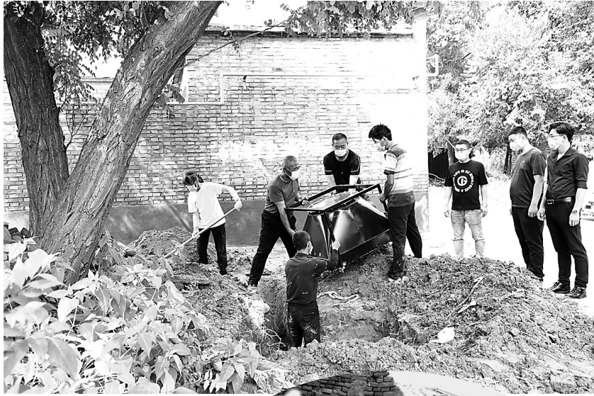
泊头市富镇姜屯村已安装普惠“表井一体”设备90余套，整个工程已接近尾声。 陈雷 摄
