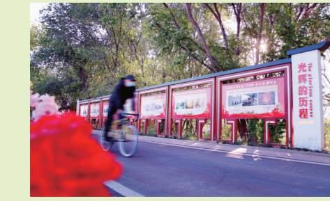
东光县运河段堤顶路
