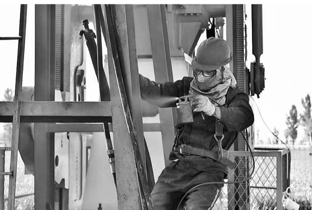
日前,任丘市华北油田作业的工人们,正抓紧对抽油机设备进行保养维护,确保生产安全运行。 张国强 李佳芳 摄
