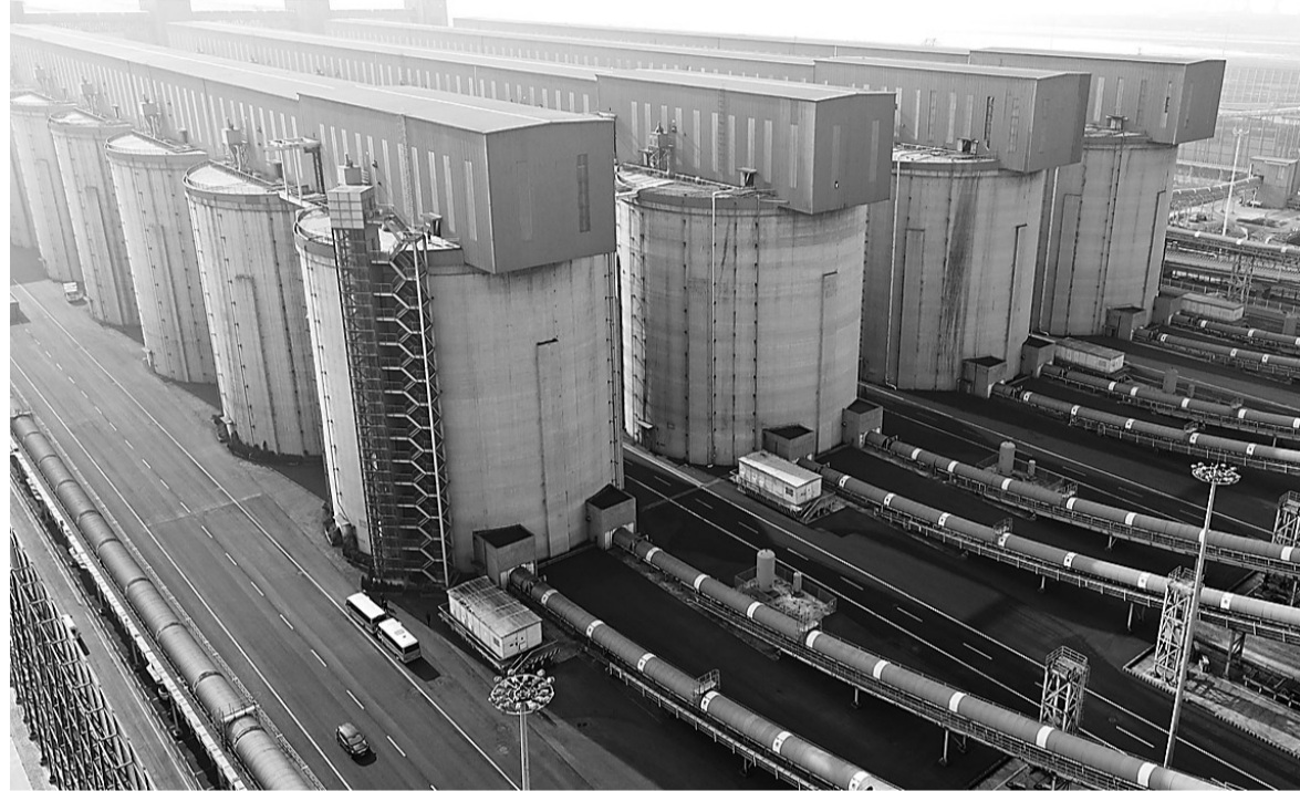
近日，国家能源集团黄骅港煤炭码头筒仓储煤设施经过10年的平稳运行，累计储煤煤炭达8.2亿吨。在为国家能源稳定供应提供有力保障的同时，实现了对煤炭存放与转运过程中的扬尘精准控制，为黄骅港打造绿色港口发挥了重要作用。
