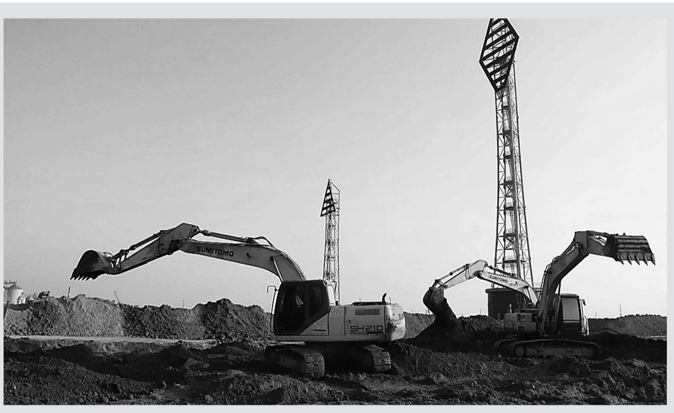
今年以来,河北渤投集团投资62.1亿元建设黄骅港综合物流枢纽工程。这个项目包含6.2公里的综合物流园区铁路专用线、物流中心、国际物流中心、物流园港口散杂货堆存区、1号和2号两个10万吨级通用泊位以及双向12公里的综合皮带机运输工程,使黄骅港成为功能更为完备、服务更为完善的大物流生态圈。张辰兆 摄
