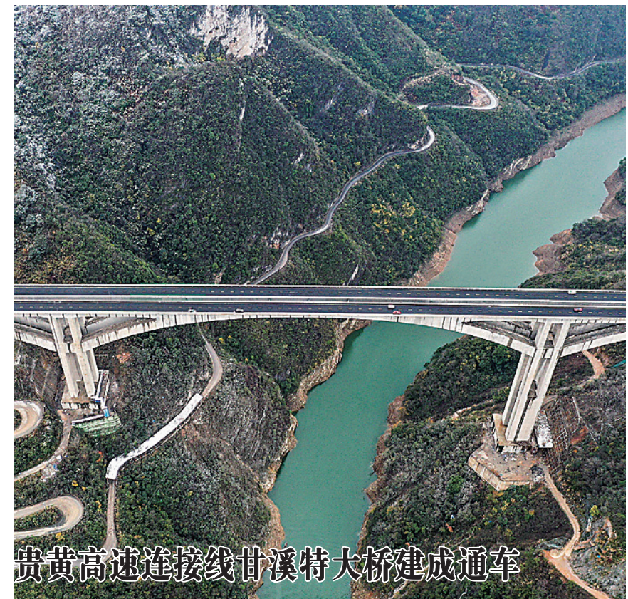
贵黄高速连接线甘溪特大大桥建成通车
