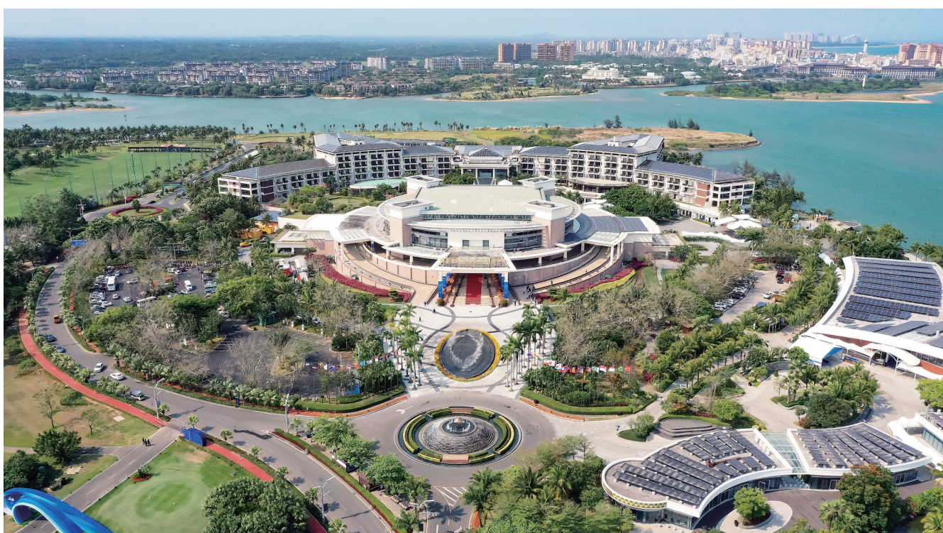
博鳌亚洲论坛国际会议中心（无人机照片）。
