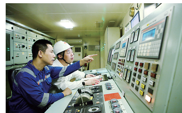
每艘挖泥船上始终保持25名员工在岗，24小时施工作业不停歇。
