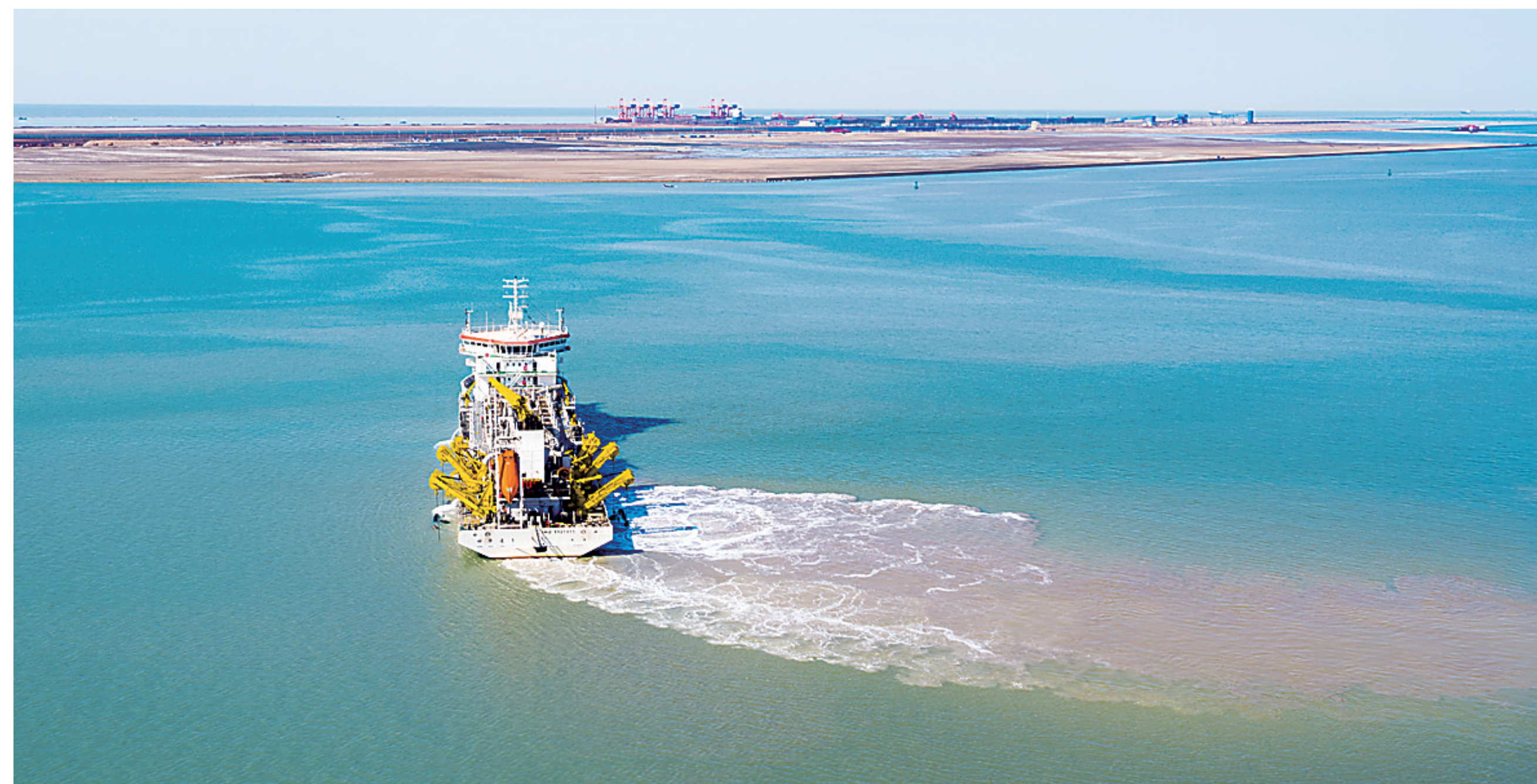
疏浚船在黄骅港海域进行作业。
