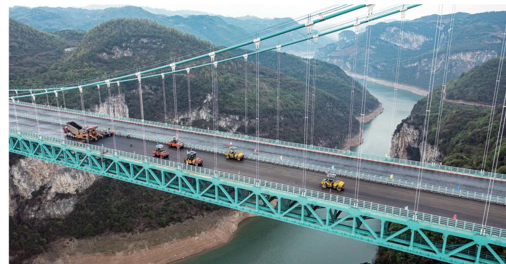
在金峰乌江大桥，贵州公路集团工人驾驶摊铺机进行桥面铺装施工。近日，贵金古（贵阳经金沙至古蔺）高速金峰乌江大桥建设项目已全面进入桥面铺装施工阶段。金峰乌江大桥是贵金古高速公路项目的重要控制性工程，桥梁全长1473.5米。
