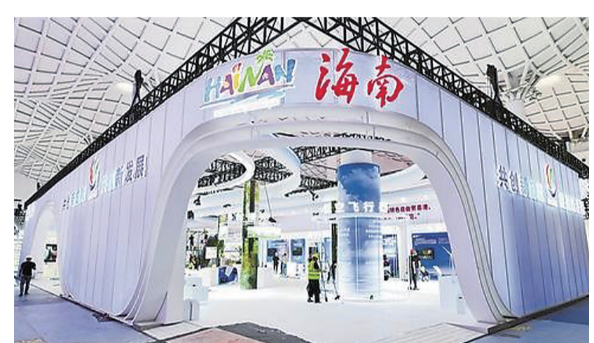
工人在海南国际会展中心内施工。 新华社发
