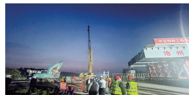
5月31日7时15分，石黄高速公路沧州主城区互通立交工程施工现场，随着重达935吨的首件预制箱梁稳稳落在石黄跨线桥的预制桥墩上，沧州主城区互通立交工程钢箱梁架设顺利完成，这意味着整个互通工程接近尾声。石黄高速公路在沧州主城区的又一个出入口——沧州（收费）站，也将在不久迎来全面通车。
