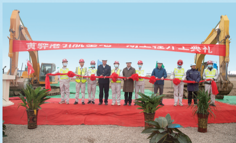
2021年3月18日,黄骅港引航基地一期工程奠基
