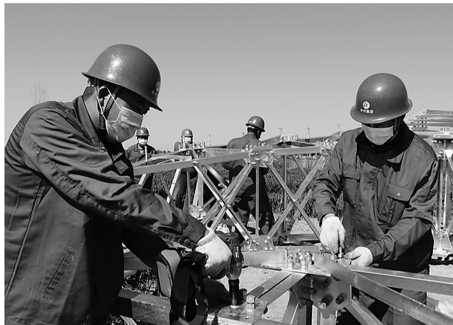
日前,由沧州中兴集团线路分公司承建的泊头后河110KV线路工程成功投运,有效解决了泊头市日益增长的负荷需求,全面保障迎峰度夏期间电网安全稳定运行。因为工程运行前,工作人员战酷暑全力攻坚,严把工程质量关。
