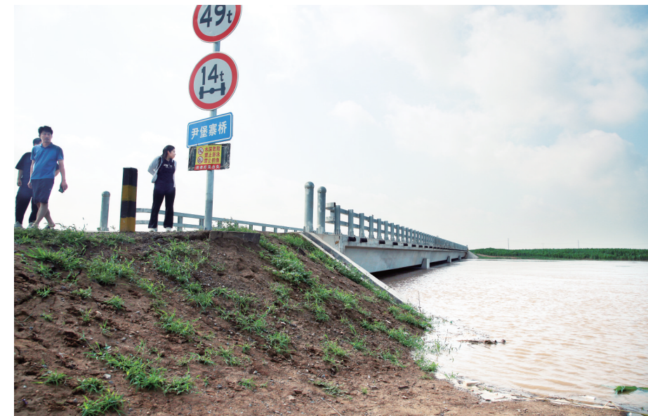
8月2日，防汛人员在尹堡寨桥值守。 殷实 摄
