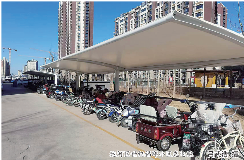
运河区世纪福邸小区充电桩 吕武浩摄
