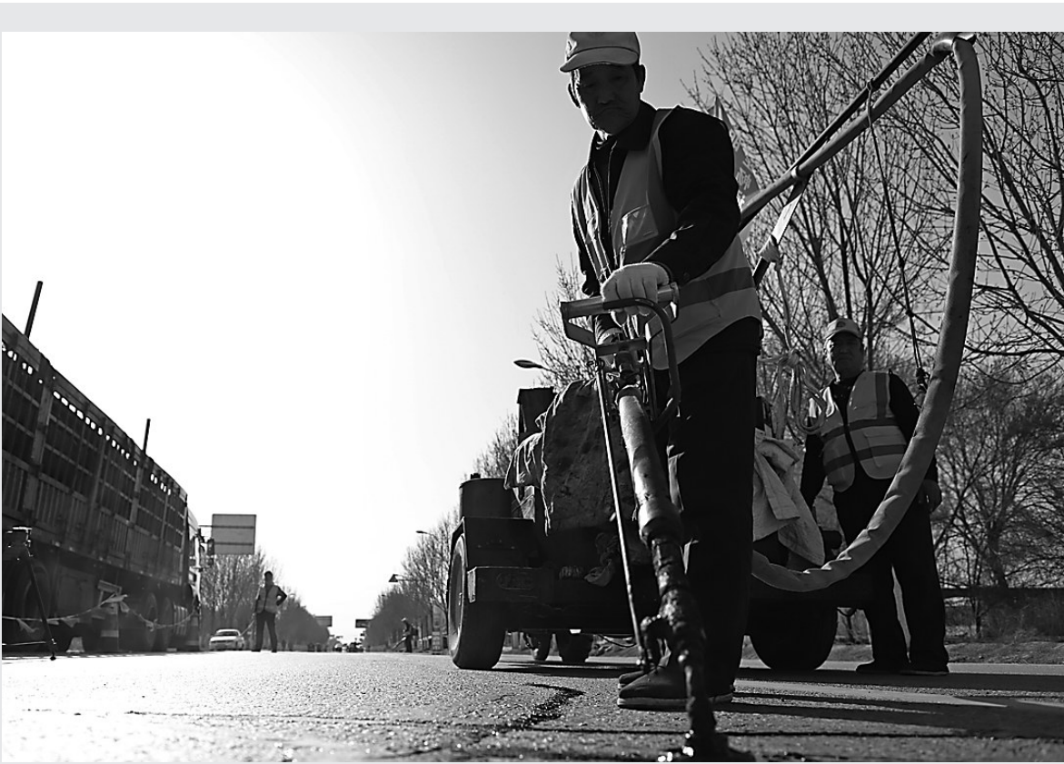
连日来，孟村回族自治县抢抓春季“黄金期”进行公路养护。截至目前，已完成国省干道公路养护、公路灌缝31000余延米，补植沿路各类观赏树木3500余株，施画补画路面标线17.93公里。图为工人们正在进行路面灌缝作业。
