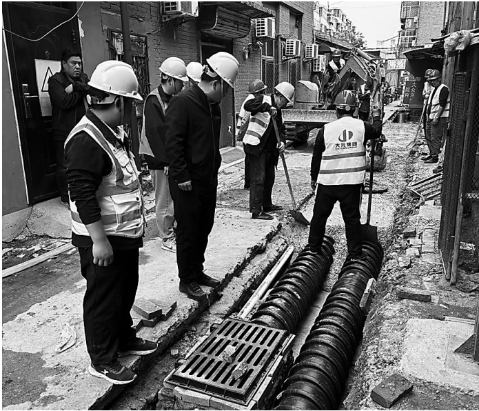
自沧州市城区排水治理项目开工以来，大元集团七公司迅速成立项目指挥领导小组，抓紧布置施工现场、分配任务，确保40个小区的排水治理项目汛期前投入使用。目前已开工11个小区，竣工2个小区。 王元元 摄
