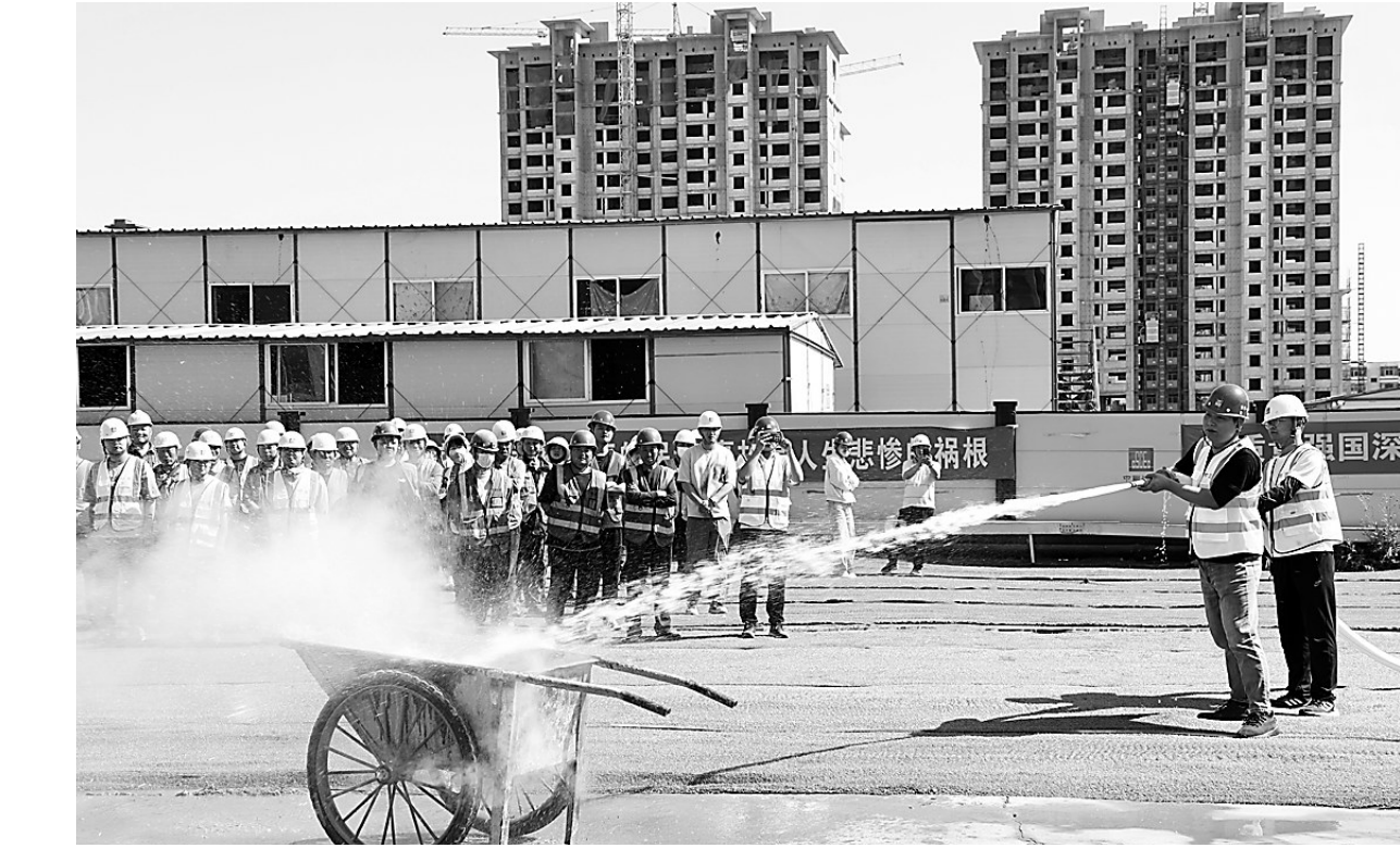
5月12日是第16个全国防灾减灾日。昨天，新华区住房和城乡建设局在海韵中区施工现场组织安全生产演练，提高建筑工人的防灾减灾意识，增强防灾减灾能力。 陈雷 摄
