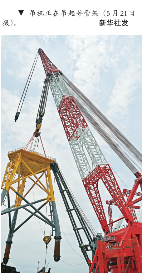
▲ 这是海上风电机组施工现场（5月21日摄）。5月21日，记者前往广西首个海上风电示范项目——防城港海上风电示范项目A场址，探访正在加紧建设的海上风电场。该项目将建设83台单机容量8.5兆瓦的风电机组。目前，已安装风电机组29台，其中15台已实现并网发电。新华社发
