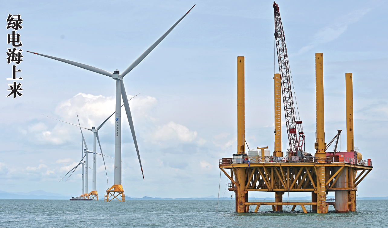
▲ 这是海上风电机组施工现场（5月21日摄）。5月21日，记者前往广西首个海上风电示范项目——防城港海上风电示范项目A场址，探访正在加紧建设的海上风电场。该项目将建设83台单机容量8.5兆瓦的风电机组。目前，已安装风电机组29台，其中15台已实现并网发电。新华社发
