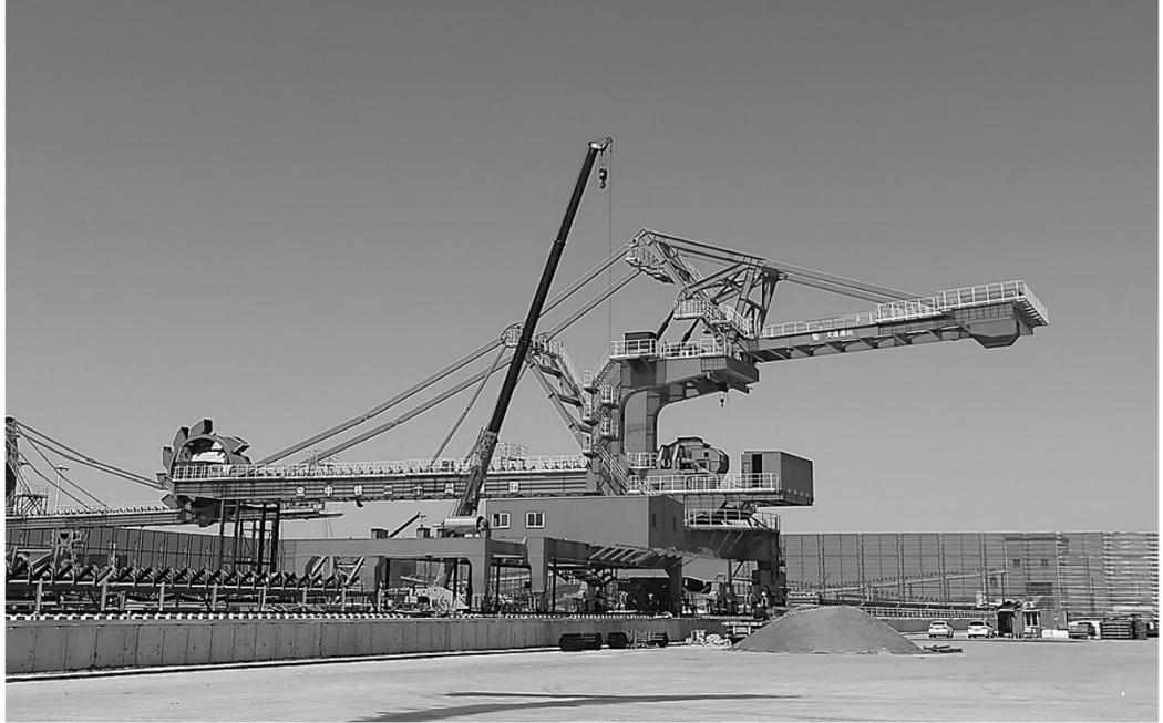
5月22日，黄骅港大宗散货码头煤炭堆场工程正在进行堆取料机安装作业。煤炭堆场项目位于黄骅港散货港区，总投资约15.72亿元，主要建设煤炭（兼顺矿石）的储运设施和相关配套设施，项目预计于9月完工，建成后，解决腹地内企业和贸易商
