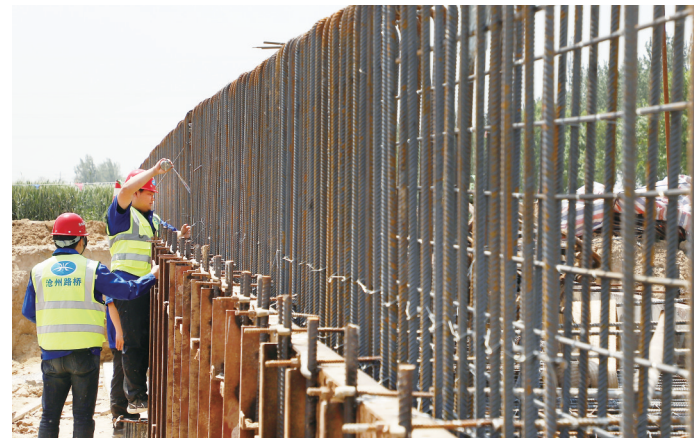
日前，G338孟村南皮界至南皮县黄家洼段改建工程施工正酣。该路段路线全长34.529公里，建成后将进一步提升路网水平和干线公路通行能力。 魏志广 刘文杰 董国池 摄
