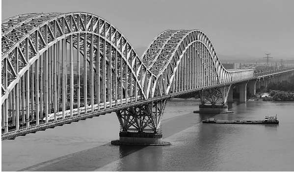
6月15日，上海—上海虹桥的超级“环线”列车通过南京大胜关长江大桥。
