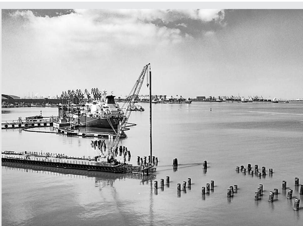
日前，在黄骅港煤炭港区油品码头施工现场，工人正在进行钢管桩沉桩作业。该项目位于黄骅港煤炭港区液体化工码头作业区东端，将建设1个8万吨级油品泊位，主要承担渤海湾及南海海洋原油上岸的运输功能。
