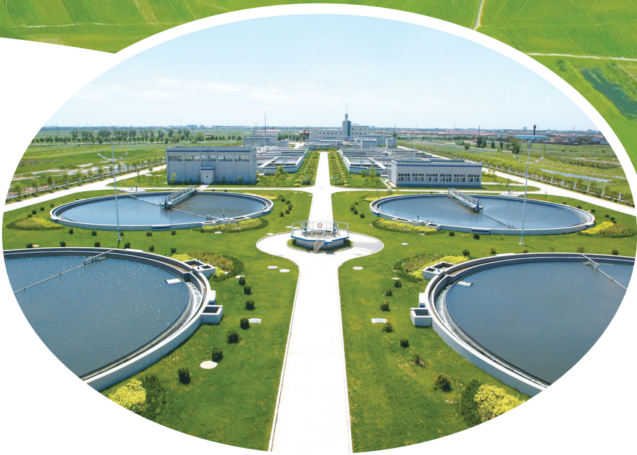
运东污水处理厂
