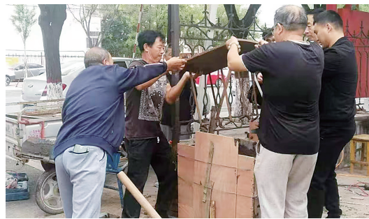
业委会成员修补小区破损路面。
