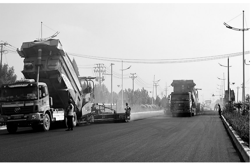
大力抓好养护工程施工工作,做好津汕高速青县连接线、廊沧高速沧州西绕城连接线、大广高速尚村连接线、331省道良各庄桥(上行)等
