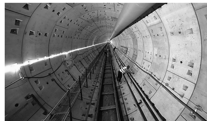
10月5日，北京地铁13号线扩能提升工程回龙观西站至文华路站盾构区间隧道双线贯通。
